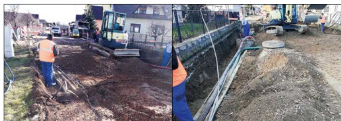
V naselju Zg. Hajdina potekajo obsežna gradbena dela. Foto: arhiv občinske uprave, TM
